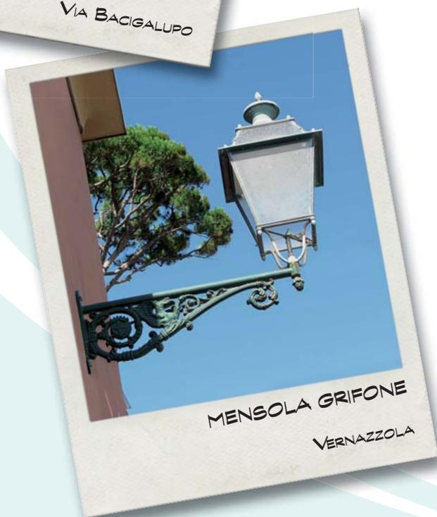
► Mensole riprodotte dagli originali d'epoca per l'illuminazione a gas del centro storico. Sono realizzate come allora in un'unica fusione accuratamente lavorata, con anima in ferro affogata nella fusione per il passaggio cavi nell'asse orizzontale. Il fissaggio a muro avviene con perni in acciaio inox e tasselli ad espansione.
